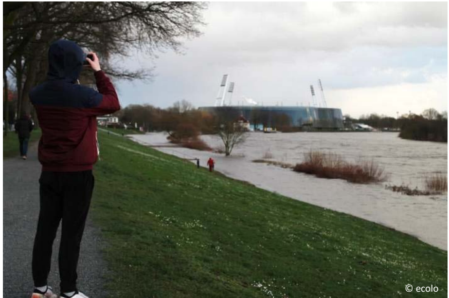
Abbildung 8: Bei Sturmfluten wie im Februar 2020 stehen die meisten Wege unterhalb des Deichs unter Wasser.
